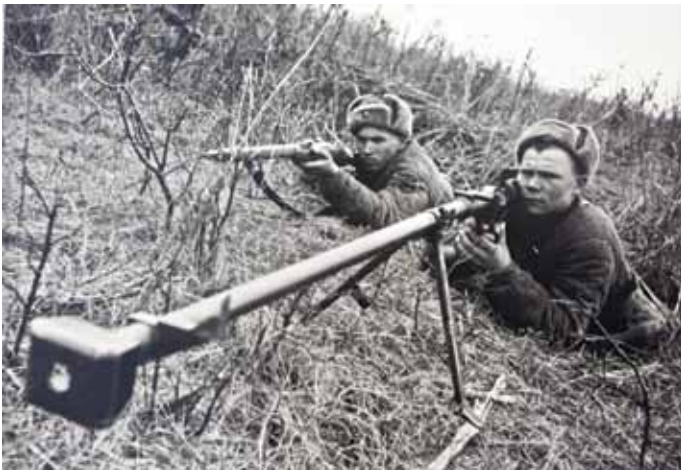
Противотанковое ружьё В.А. Дегтярёва (ПТРД, Ижевский завод) было мощным оружием — на дистанции до 300 м его пуля пробивала броню толщиной 35–40 мм
